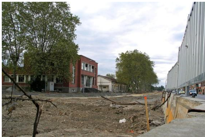
Terrassement de la plateforme sur l'ancien site Grande-Bretagne, le 31 août 2009
