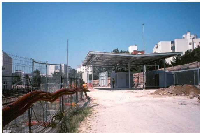
Construction du dépôt provisoire de Lagny, le 30 juin 2009 © Patrick KIRSTETTER
