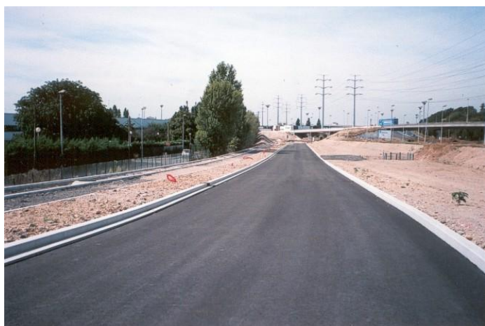
Avancement du chantier du TCSP vers Bonneuil, mi-août 2009. Le site propre en sortie de l'échangeur Pompadour. A gauche, le centre bus de Créteil.
