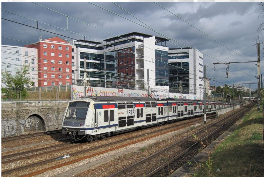
Rame M12N s'engageant dans la trémie entre Vincennes et Val de Fontenay, sur la branche « Marne-la-Vallée », le 4 octobre 2009
