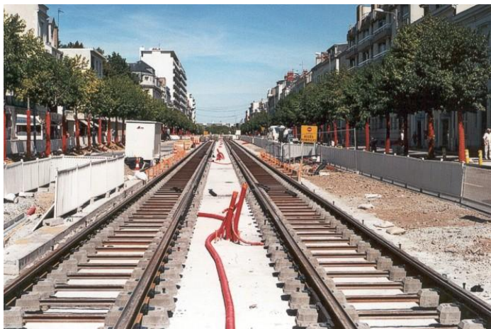
Après la plateforme, les rails sont en cours de pose sur le boulevard Foch
