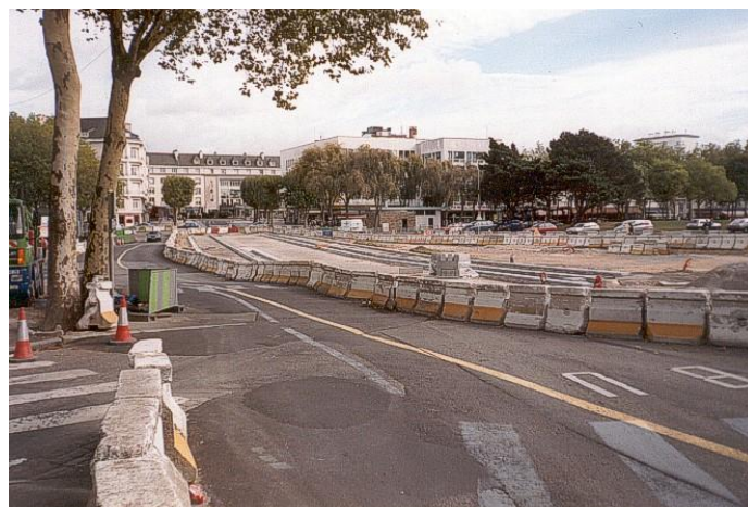
Le site propre et la station « Sécurité-Sociale » en direction de la gare d'échanges, le 4 septembre 2006 © Alain ROGER
