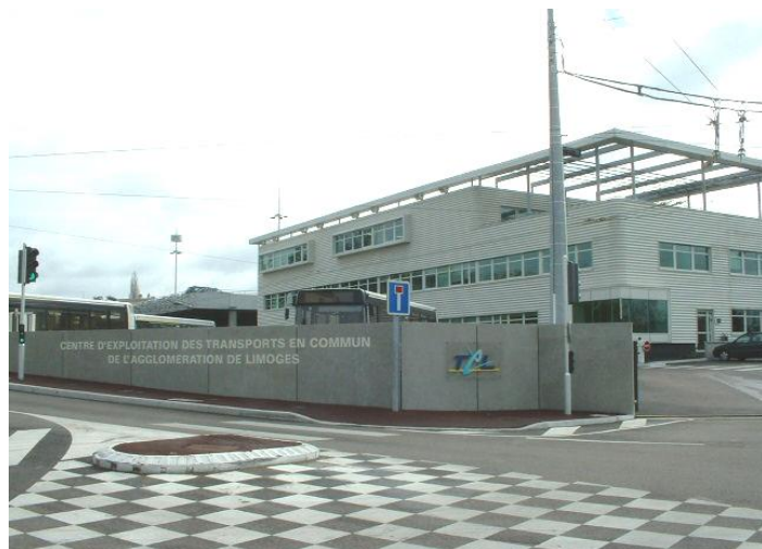
Le dépôt du Clos Moreau après sa reconstruction © Xavier LANSADÉ
