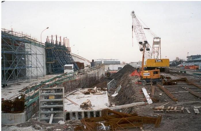
Construction de la nouvelle trémie avec à sa droite la chape béton qui accueillera la voie d'accès au dépôt.
