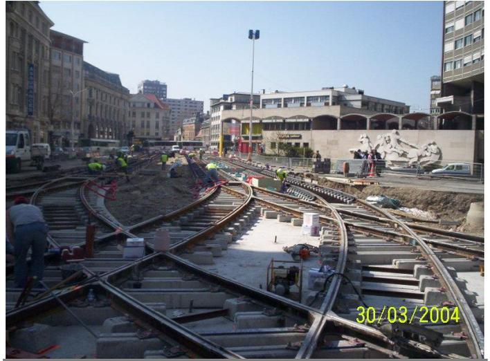
Pose des rails et aiguillages à la Porte Jeune au centre de Mulhouse – Véritable centre du futur réseau Tramway
