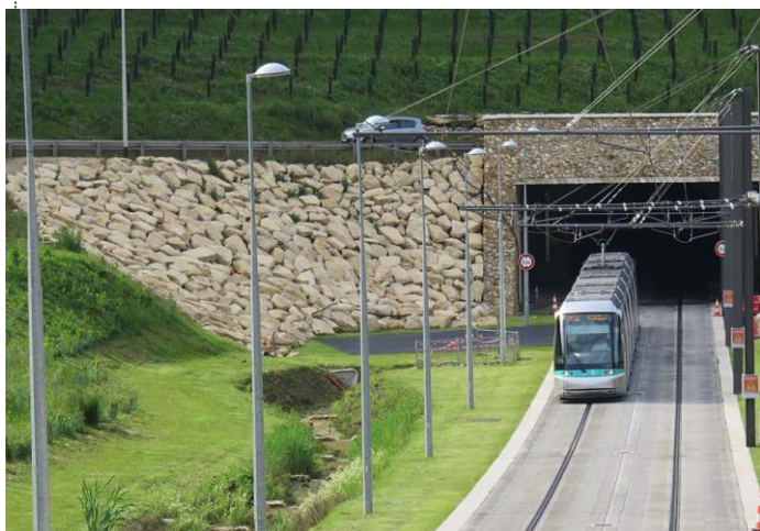
Vélizy – La rame n°601 sortant du tunnel de Viroflay vers Châtillon © Christophe DECAUX, 28 mai 2016
