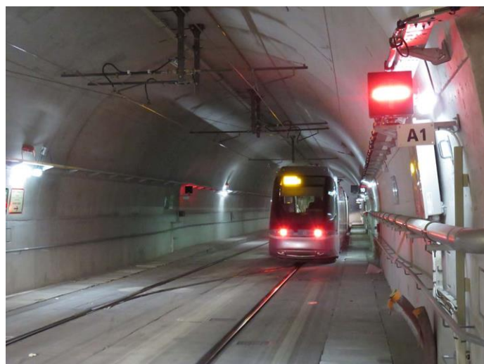
Viroflay - La rame n°602 dans le tiroir d'arrière-gare du terminus Viroflay-Rive-Droite © Christophe DECAUX, 28 mai 2016
