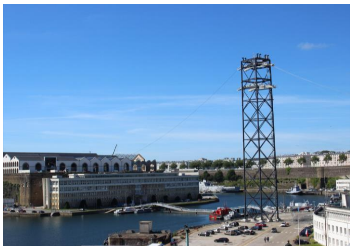
Brest – Le pylône du téléphérique érigé en mai, vu en juillet 2016
