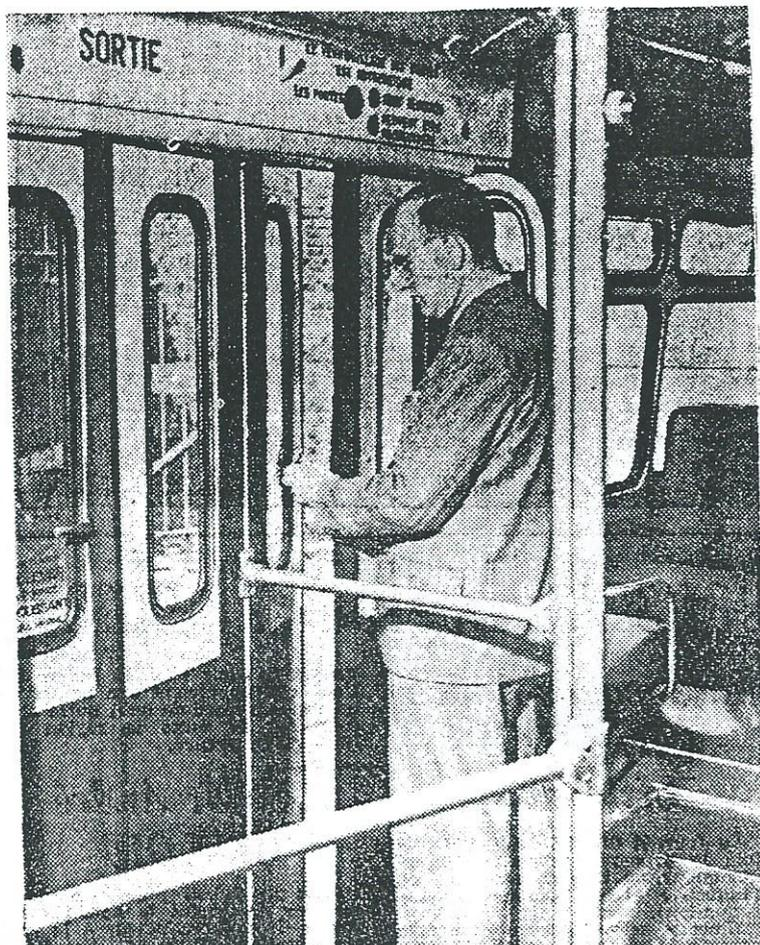
Ci-dessus : pour descendre, il suffit de soulever une poignée et de pousser légèrement le vantail de gauche. Ci-dessous : une vue de l'intérieur du « bus ».
